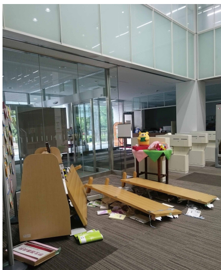
展示用書架(中央館) 反対に倒れていたらガラスが割れていた
