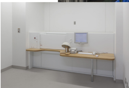
自動書庫と出納ステーション 膨大な資料の中から要求した図書を出納ステーションまで搬送する。
