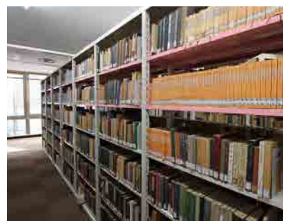
固定書架の上段に取り付けられた「傾斜スライド棚」(ピンク色の部分)。地震のときの本の落下を防ぐ
