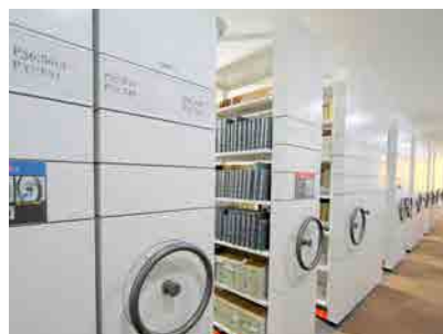
1階書庫の移動式書架。地震対策として免震装置が装備されている
