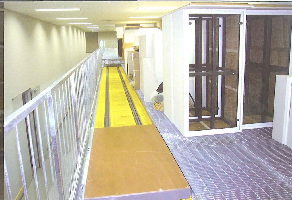
改修後のバックヤード(上層) レールと専用の荷台を取り付けた。
